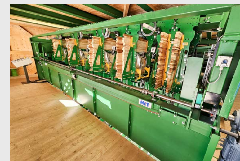
■ Paketverpackungsplatz vor der automatischen Umreifung
