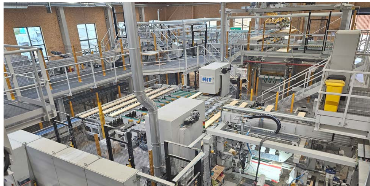
■ Gesamtansicht Keilzinkanlage TKZ – dahinter Entstapelung
